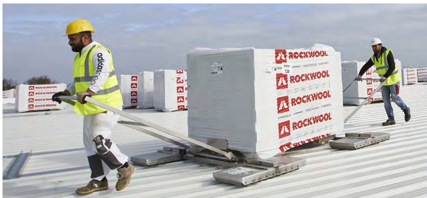
Für den einfachen und sicheren Transport von Großgebinden auf Trapezprofilen bietet ROCKWOOL das Transportgerät Lift and Roller an.
