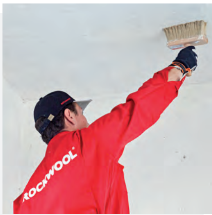
A fogadó felület megfelelő előkészítése, tisztítása javítja a ragasztó tapadását
