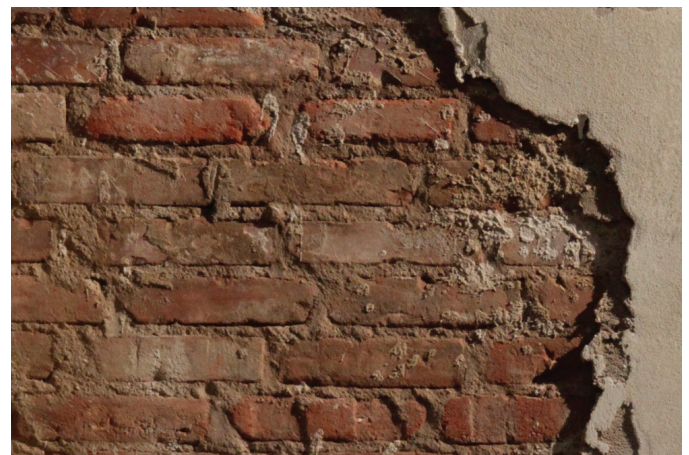
Exempel på vägg som bara kan repareras med en större insats för att uppfylla kraven.
