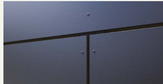
2. Kompaktlaminat- og fibersementplater: Skjøtene må være minst 10 mm brede.
