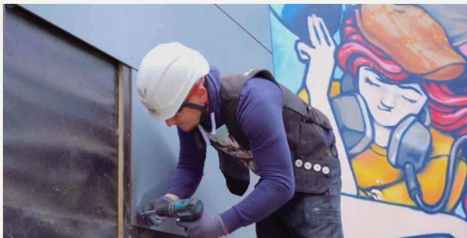
Enkel demontering av Rockpanel plater
