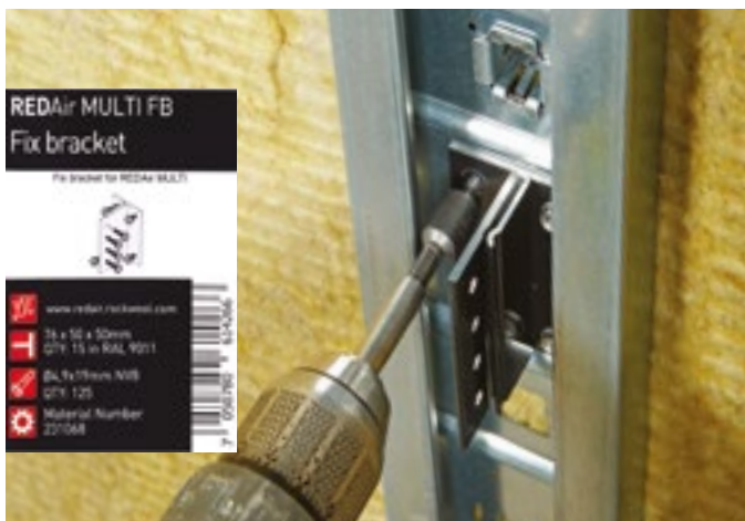
REDAir Multi FB Fixbeslag är svart med svart etikett. Beslaget har fyra runda hål i den utstickande flänsen.
