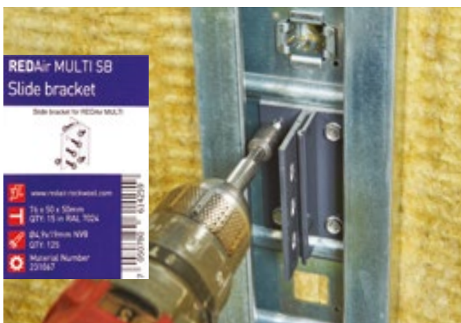
REDAir Multi SB Glidbeslag är grått med blå etikett. Beslaget har tre ovala hål i den utstickande flänsen.
