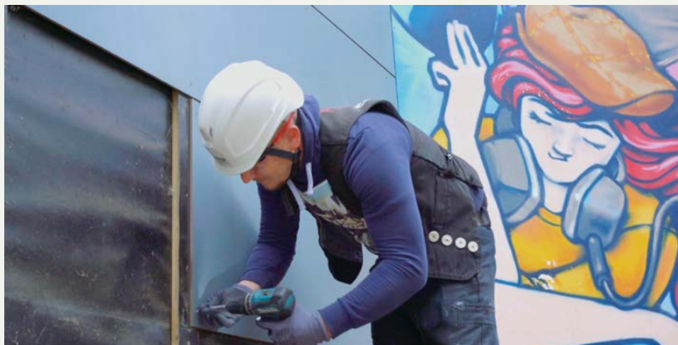
Łatwy demontaż płyt Rockpanel
