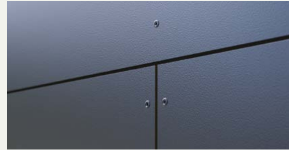
1. Rockpanel: Wysoka stabilność wymiarowa pozwala na wąskie szczeliny między płytami.
