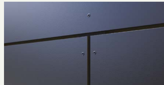
2. Kompaktlaminat- och fibercementskivor: Fogarna måste vara minst 10 mm breda.
