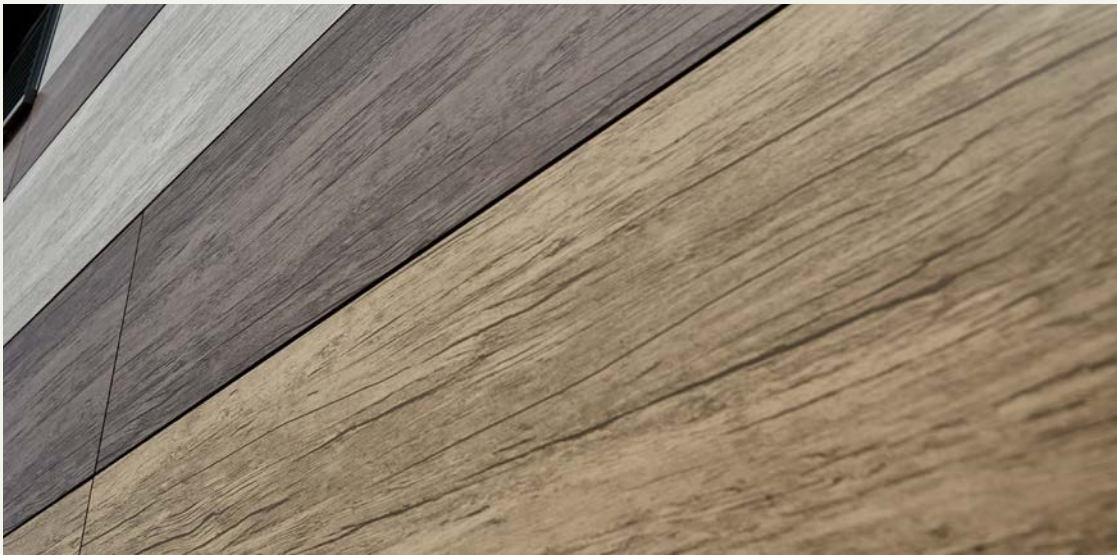
Dold infästning - syns inte från utsidan
